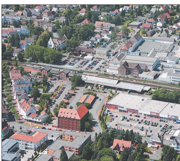
sich das Areal nahe der Bahn verändert hat. Der Tabakspeicher ist geblieben.
